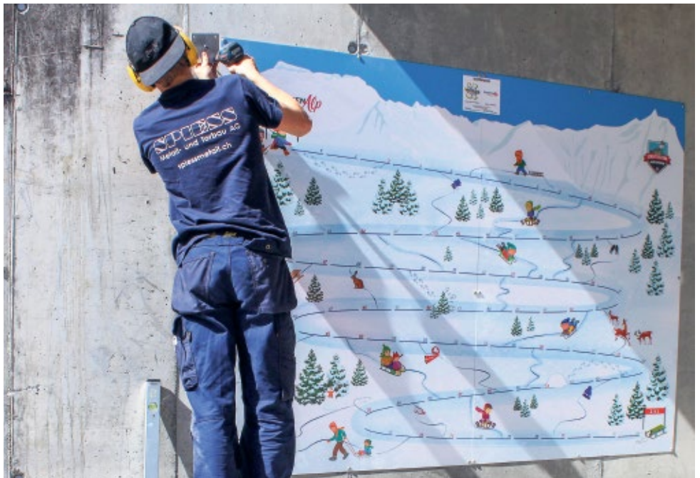
Der Spielposten «Schlittelspass» bei der Tschentenbahn wird montiert.
